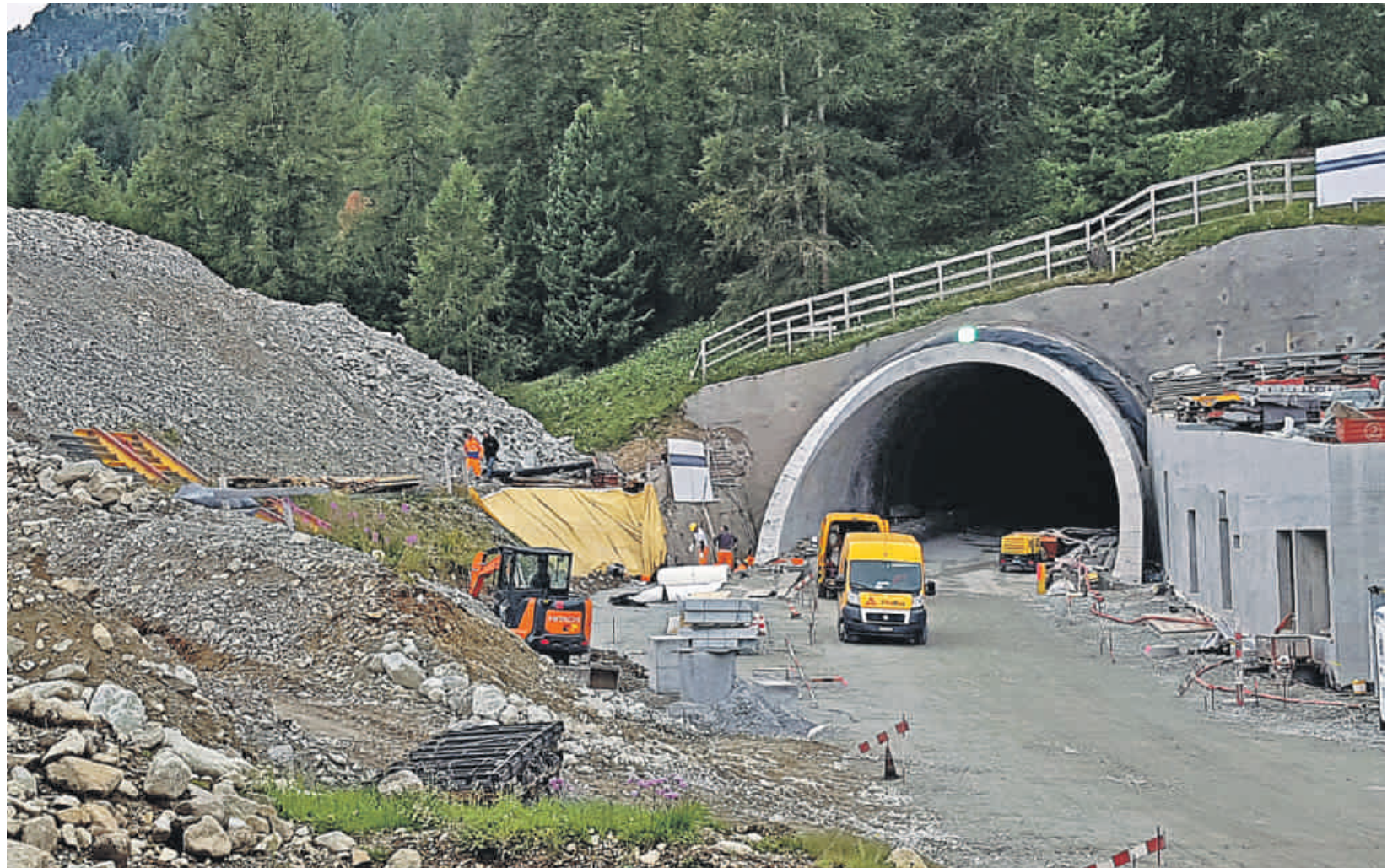
Zurzeit sind beim 750 Meter langen Tunnel zwischen Pignia und Piz Sura die Innen-Ausbauarbeiten im Gang.
