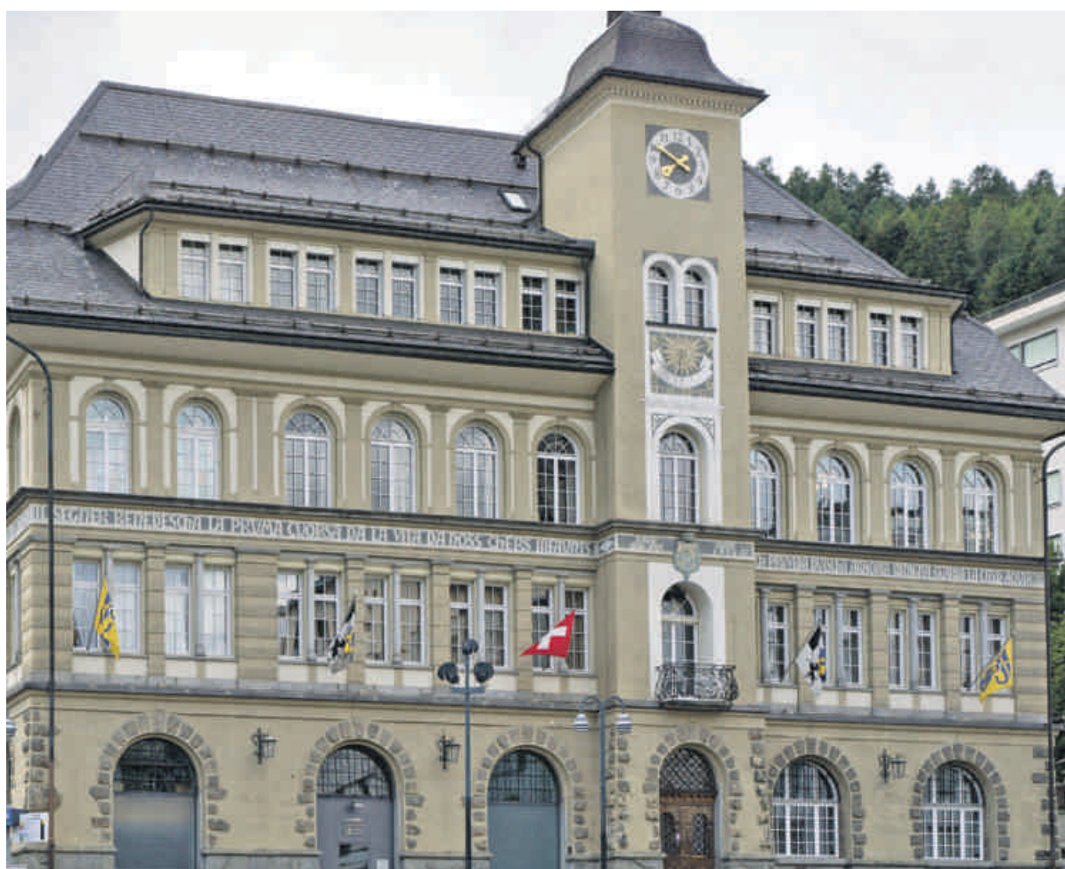
1886 erbaut, 1909 erweitert und von 1995 bis 1997 mit einem Bibliothekseinbau im Sockelgeschoss ergänzt: Im Schulhaus Dorf in St. Moritz dürften in absehbarer Zeit keine Schüler mehr unterrichtet werden. Foto: Reto Stifel
